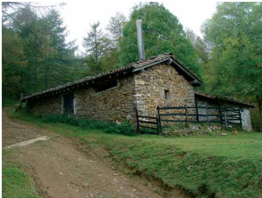
› JAONDO. Jaondoko txabola. Jaondoko txabolak areharrizkoak dira. Gorago dauden Arriurdingoak berriz, ka-reharrizkoak. (AA, 2008-10-12)
